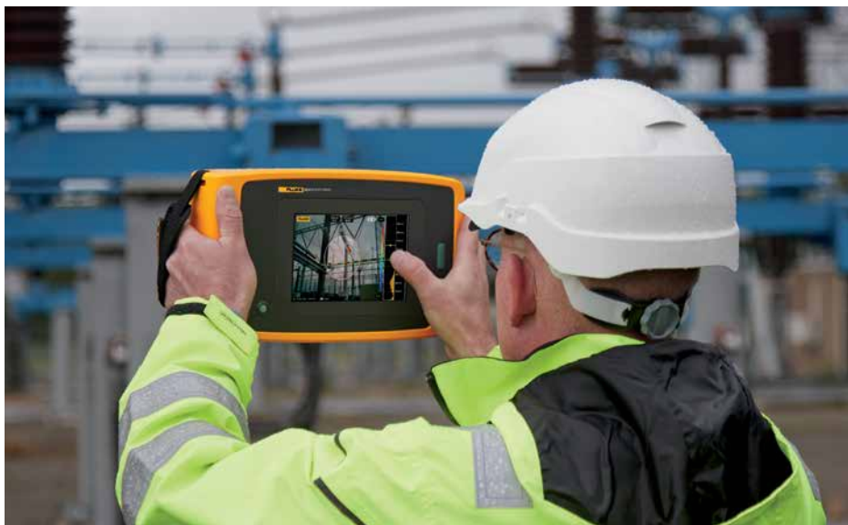
Imagem obtida com o Imageador Acústico de Precisão ii910 detectando uma descarga parcial em uma aplicação de alta tensão.
